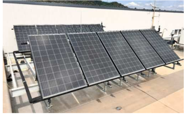
Fig. 2. Analysed PV/T system
